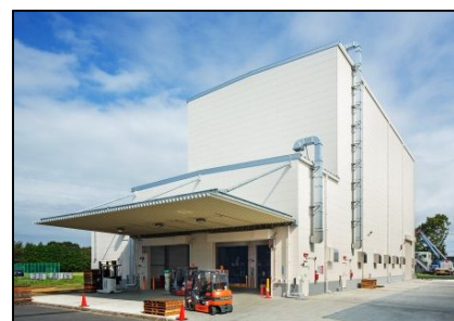
危険物自動ラック倉庫外観
