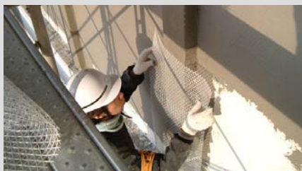
ボンドカーボピンネット工法(左) / 鉄骨ブレース接着工法(右)
