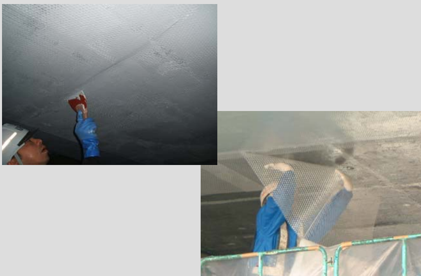
コンクリート片の剥落防止工法 ボンドKEEPメンテ工法VM-3 施工写真
