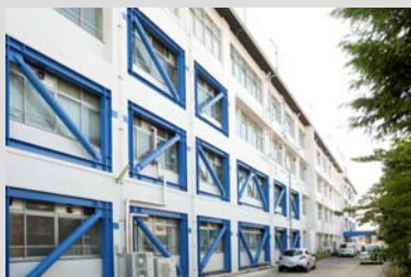
ボンドカーボピンネット工法(左) / 鉄骨ブレース接着工法(右)
