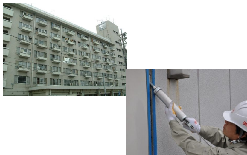
シーリング材 施工現場
