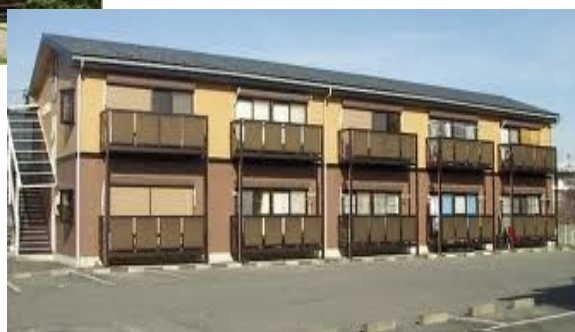
サイディング外壁材 施工例
