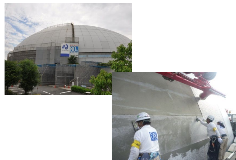
外壁剥落防止工法 施工現場
