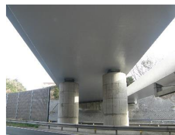
コンクリート表面保護工法
