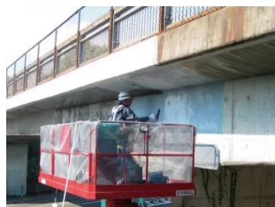
【工事事業 工事例】
