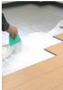
③住宅内装 床フローリングの施工風景
