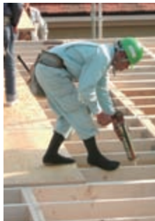
②戸建住宅二階の床板の 施工風景
