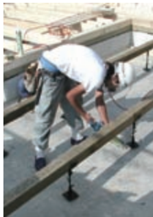
①住宅基礎組みにおける 束の施工風景
