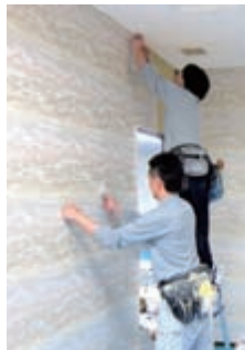
④住宅内装 壁紙貼り付け施工風景
