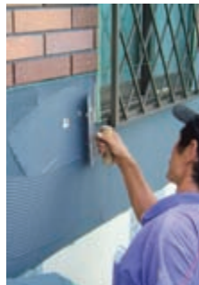
⑤住宅外装 外壁タイル施工風景
