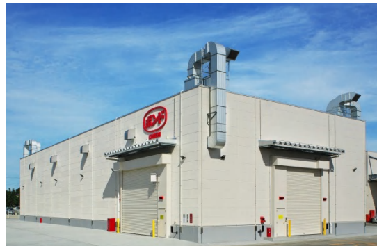
（今期新設）危険物倉庫 800パレット収納
