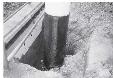
鋼柱の補強
