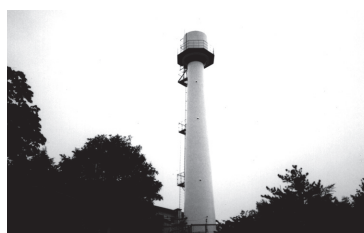
給水塔・煙突の補強
