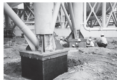
工場構造物の補強
