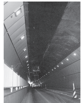
トンネルの補強
